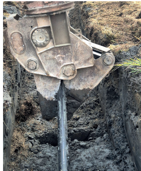
Stalen leiding verwijderen.
